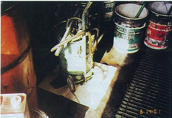
ギヤオイル等の油庫の床面 Kシート, F-50 (フロアマット)
